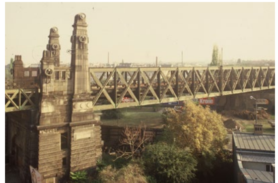
⬇ Fig. 7. Vienna, bridge “Die Brücke über die Zeile” by Otto Wagner. © Bundesdenkmalamt, Michael Oberer
